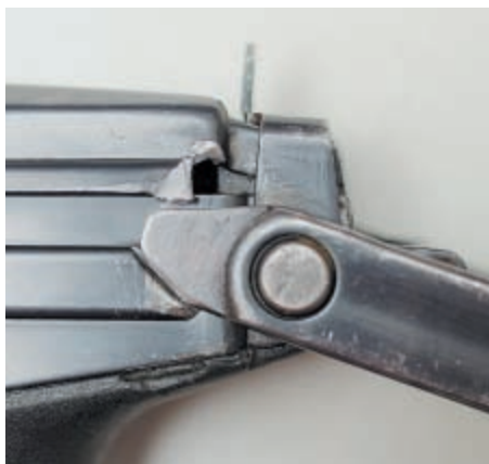
Фиксация приклада в боевом положении довольно хлипкая – он упирается в тонкие края крышки ствольной коробки
