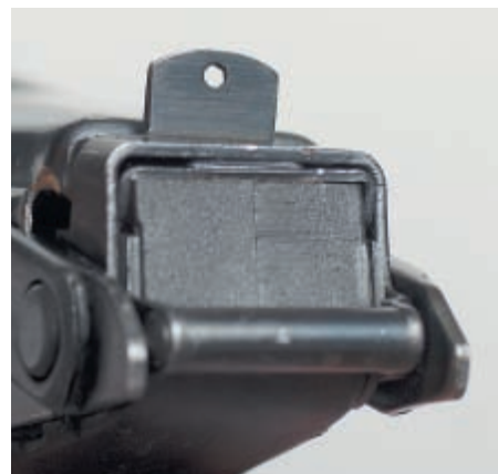
На защёлке крышки ствольной коробки расположены диоптр и задняя антабка
